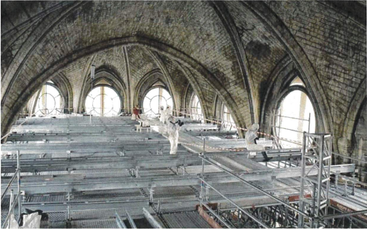
Des chercheurs inspectent les voûtes, désormais accessibles, de la cathédrale.
