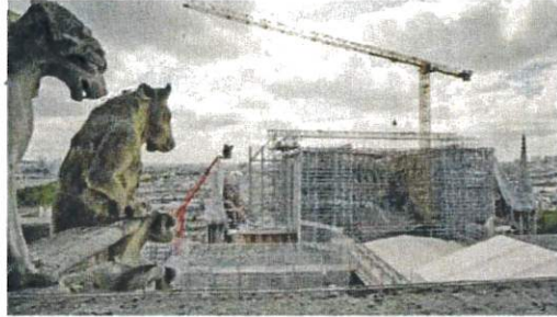
Les gargouilles veillent sur le chantier. © ARTE France - ZED
