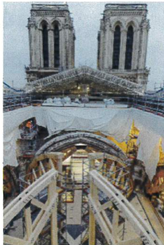
Patrick Zachmann, pour l'agence Magnum, Pose des cintres qui serviront à reconstruire les arcs de la voûte à la croisée du transept, novembre 2022
